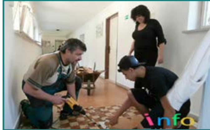
Veľká rekonštrukcia kanalizácie a interiéru Materskej školy na Kalinčiakovej ul.
