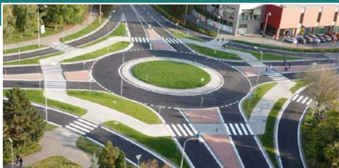
Výstavba novej kruhovej križovatky
