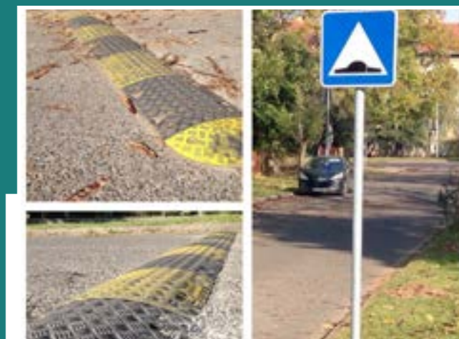
Osadenie spomaľovacích prahov pre väčšiu bezpečnosť chodcov
