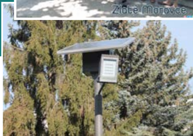
Osvetlenie Materskej škôlky na Kalinčiakovej ulici solárnymi panelmi
