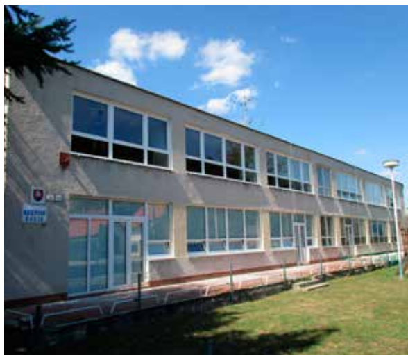
Budova MŠ Štúrova po rekonštrukcii.
