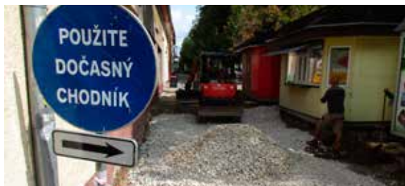
Chodník na začiatku rekonštrukcie.
