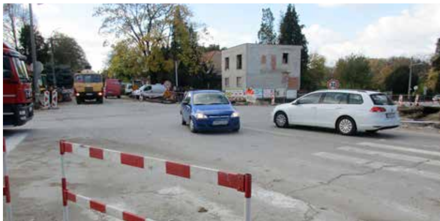
Výstavba kruhového objazdu v závere októbra.
