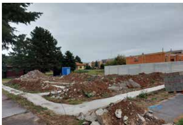
Stavba základov komunitného centra.
