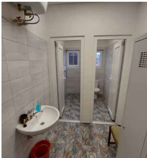
Zrekonštruované sociálne zariadenia "vážnice".
